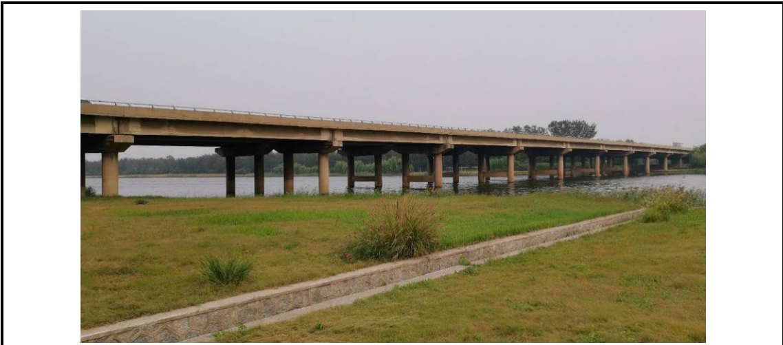
图 2.7-5 京津塘高速跨永定新河既有桥梁现状
