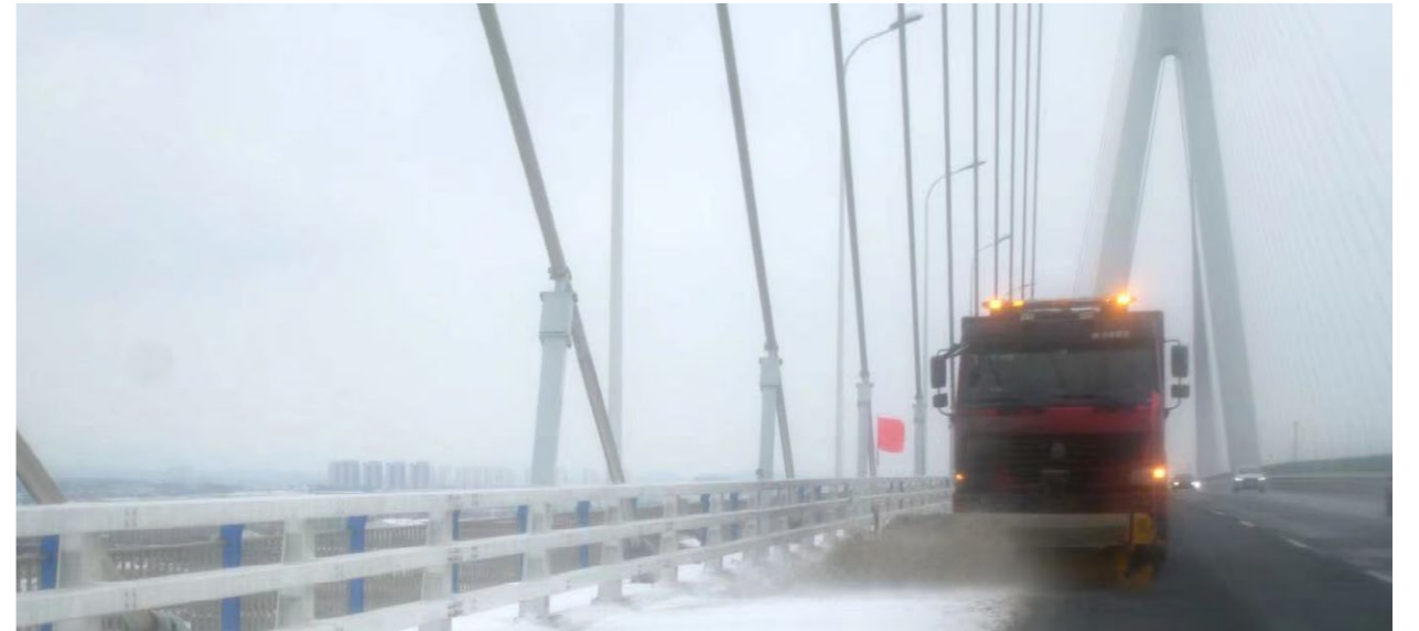
招商公路下属公司鄂东大桥实行全机械化、零结冰、零拥堵预防性应急策略，高效完成冬春季的雨雪冰冻天气的应急保畅工作
