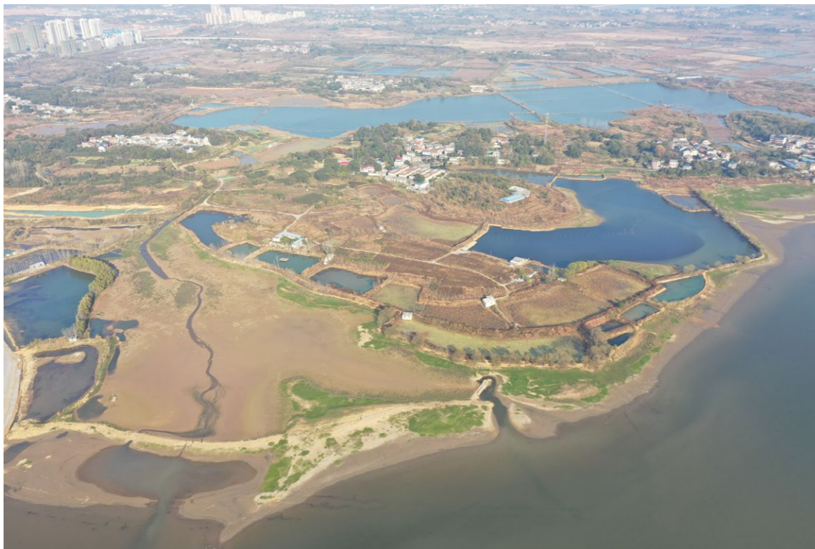
磊山湖磊山港、石家湖港水环境综合治理
