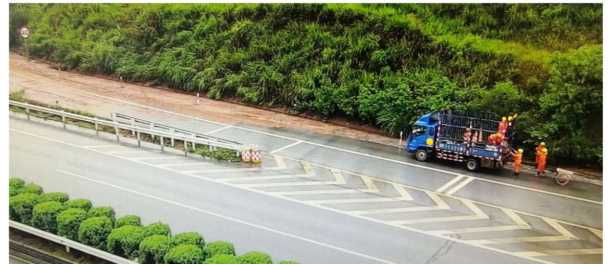
桂林公司防汛现场作业
